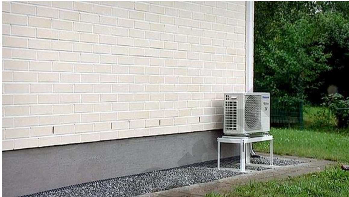
Ilmalämpöpumpun ulkoyksikkö halutaan usein sisäpihalle. Kuva: YLE / Antti Eintola
