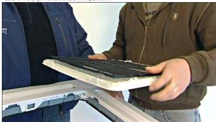
Ainoa huoltotoimenpide on muovisuodattimen puhdistus
